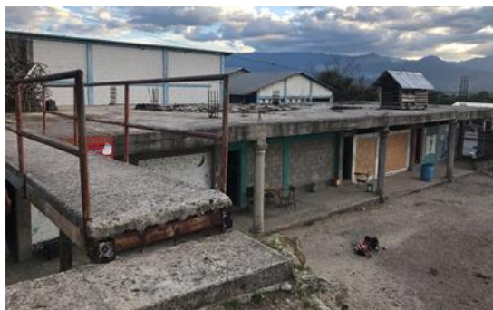
エベンエセル校（二階部分が未建設で基礎のみ）
